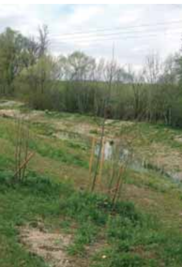
Bachrenaturierung: Auch Maßnahmen an kleinen Gewässern leisten einen Beitrag zum Hochwasserschutz.
