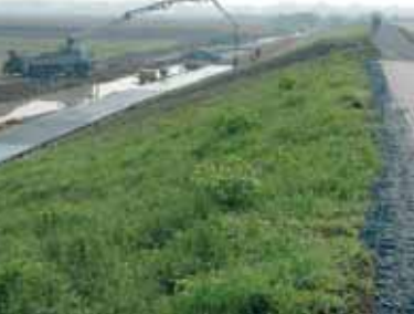
Schützt vor Hochwasser: Ein Flussdeich wird gebaut.
